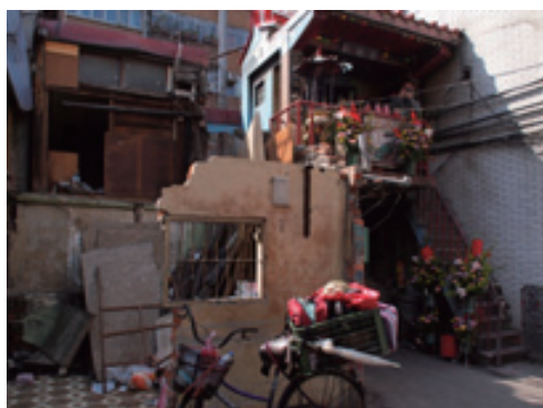
艋舺舊有的隘口原係社區防禦範門戶今只剩殘牆，舊市區之保全必須與都市設計同步。攝影／郭瓊瑩
