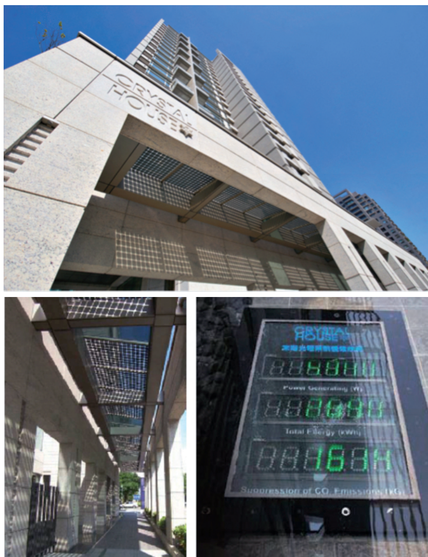
圖4 太陽能AIPV光電長廊，不僅提供大樓公設電力，減少管理費支出，藝術化的設計也使該空間美化不少，
