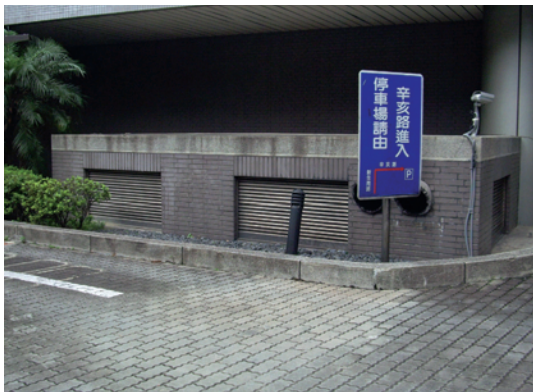
5-2 噪音與廢氣排給您(台北)
