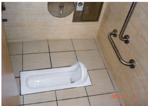
照片4 蹲式馬桶採70cm長方型便器，其正面有倒T型扶手，可供安定蹲位及上下使用。(吳明修攝)
