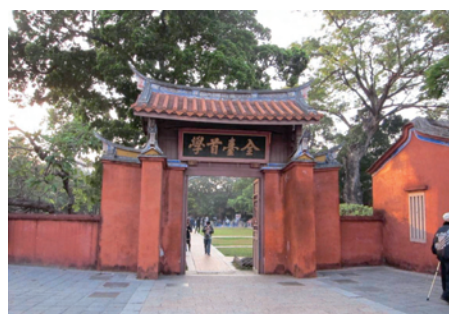
圖4 台南孔廟入口有約20公分（2階）高差，可容易改善卻未改善。攝影/作者
