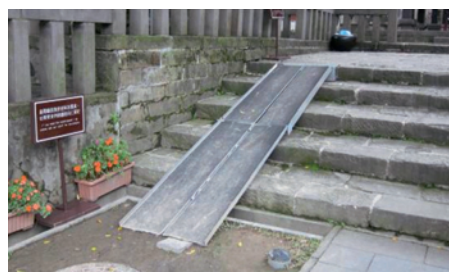
圖3 板橋林家花園，庭園通路高差處設置之活動式斜坡板，坡度過大。攝影/作者
