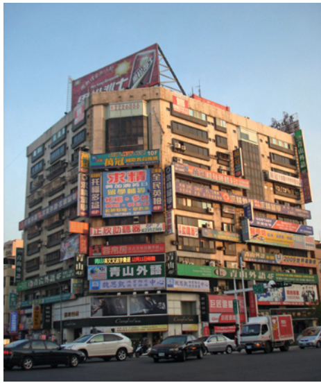
大樓立面招牌凌亂
