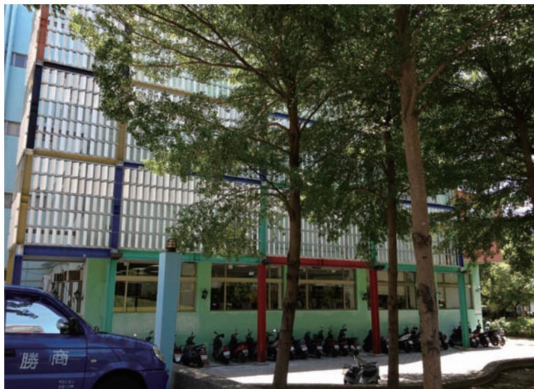
新竹文化中心正面外觀粉刷美化後現況
