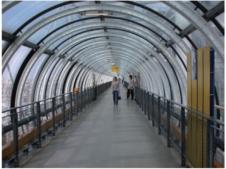
龐畢度國家藝術和文化中心骨架外露並擁有鮮豔的管線機械系統
