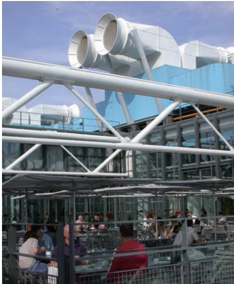
龐畢度國家藝術和文化中心所有功能結構要素的建設最初是都採用不同顏色來區別
