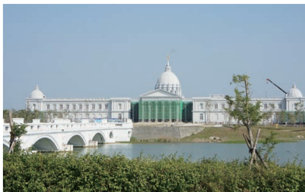
台南都會公園博物館(施工中)
