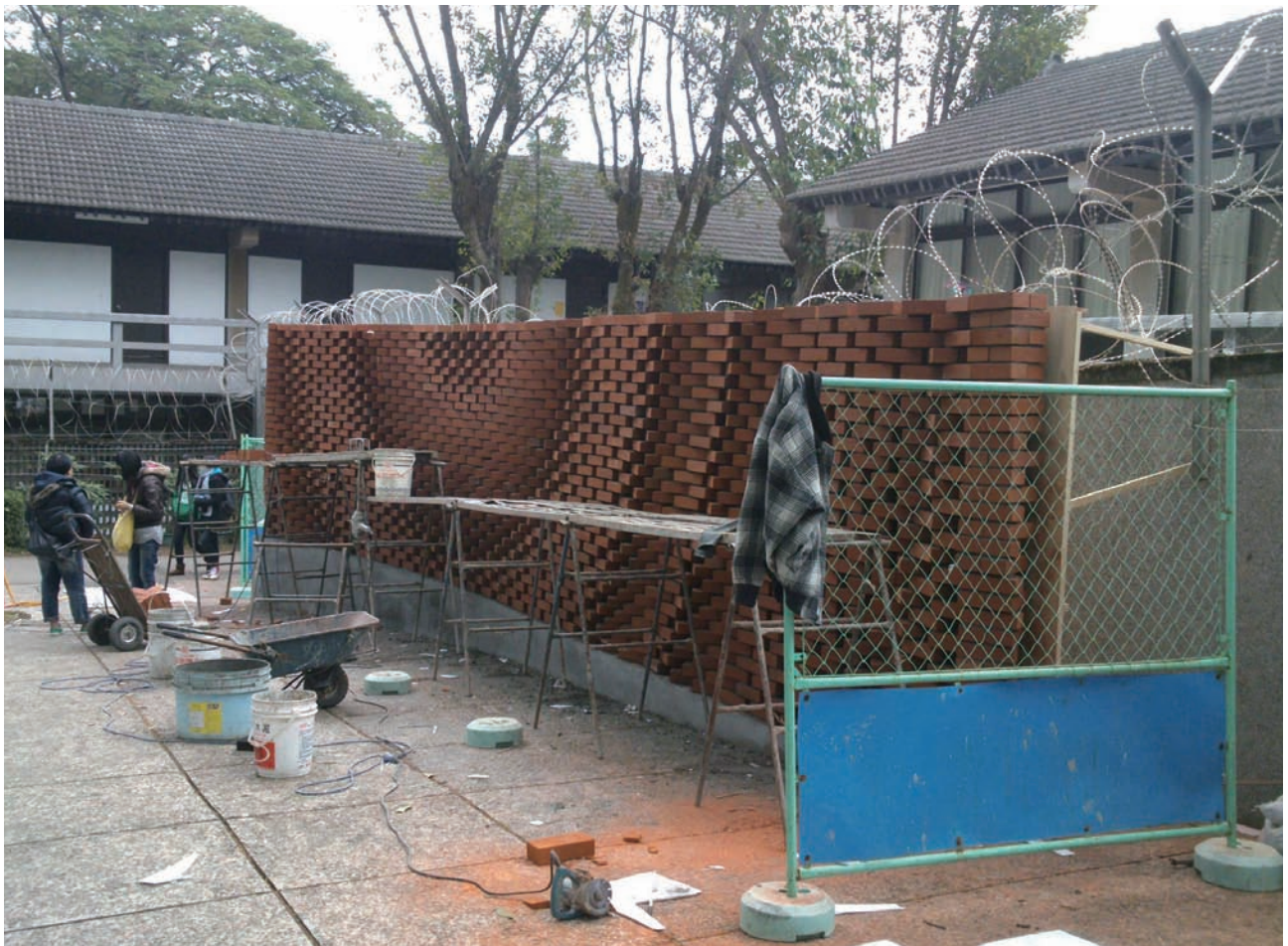
東海校園內施工中的清水磚漣漪牆 (邱浩修+蔡昱偉+丁弈理設計)
