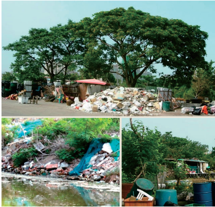
中都濕地施工前
