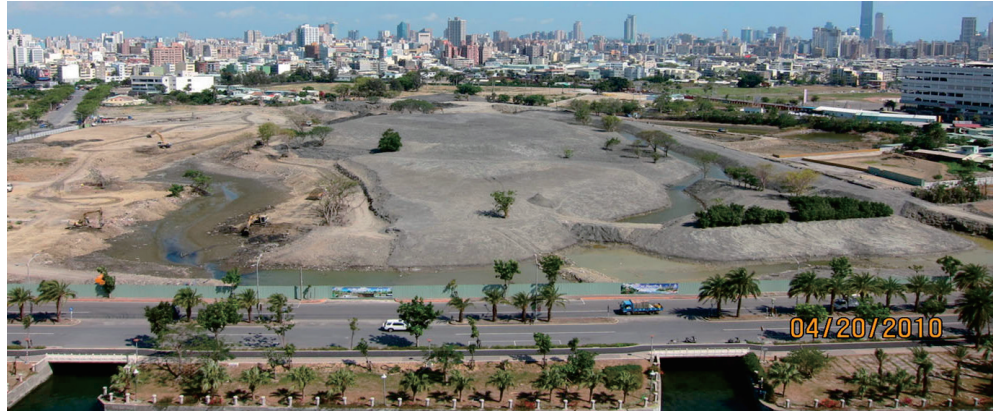
中都濕地施工中
