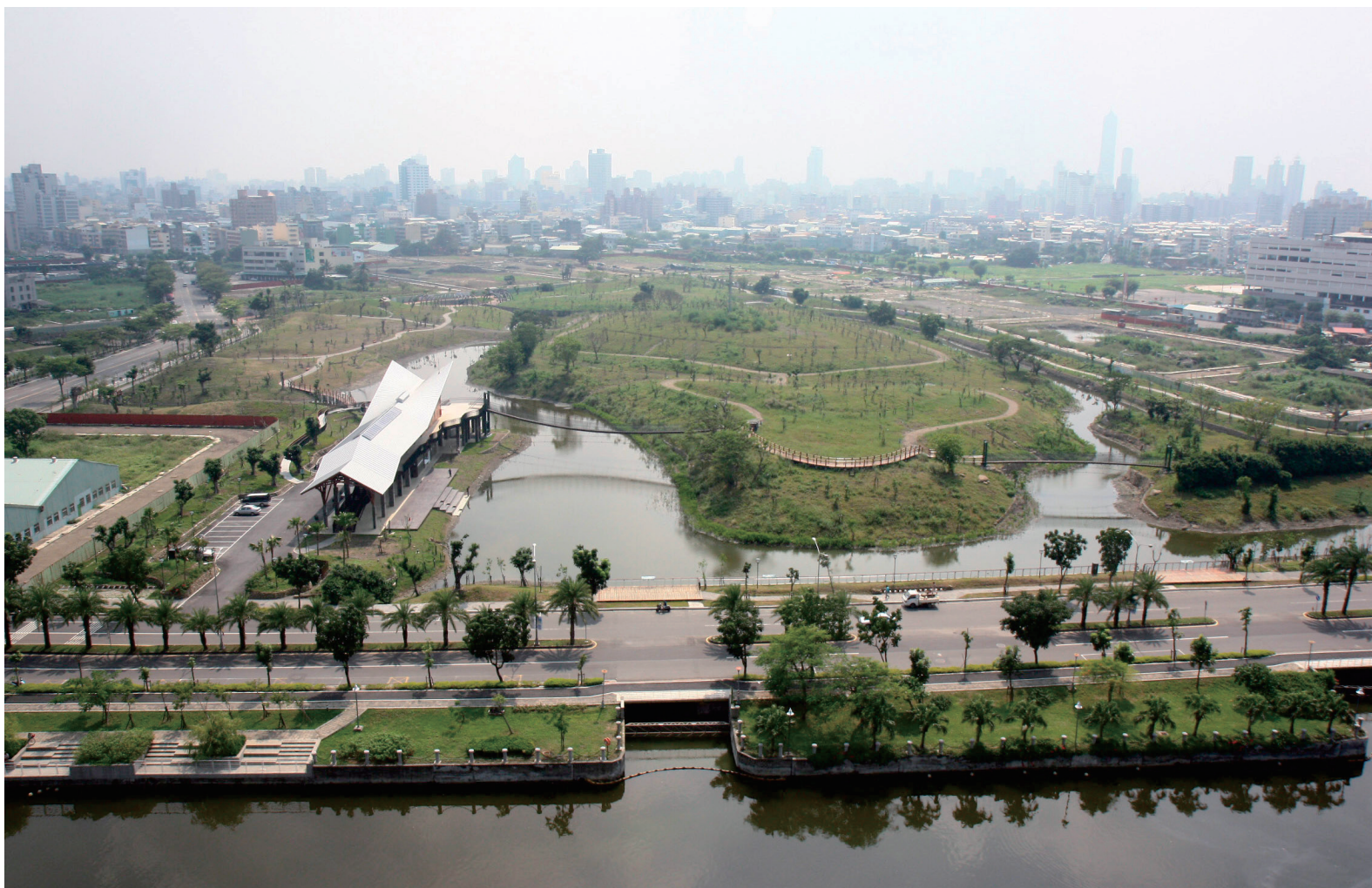
中都濕地施工後
