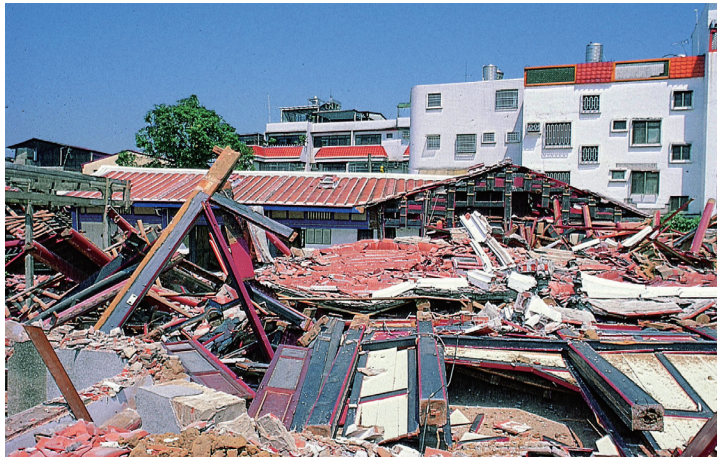
圖2 921地震霧峰林宅景薰樓倒塌
