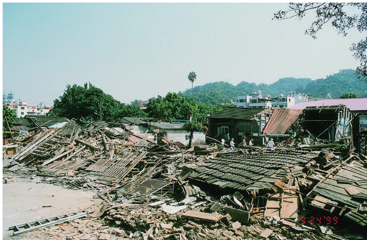
圖3 921地震霧峰林宅宮保第倒塌
