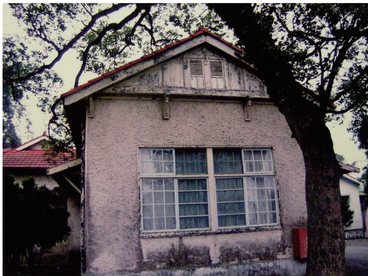
圖1 斗六糖廠招待所，可見其大開窗、複層屋頂、排熱氣窗、大樹遮蔭等。（攝影／林崇熙）
