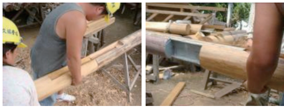
照片3 鋼版補強續接
