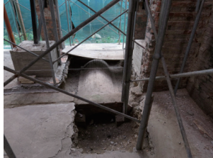
照片10 外廊下方設拱砌通道，提供室內高架木地板通風。
