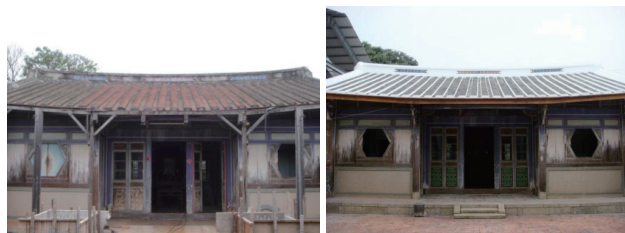
照片1 筱雲山莊篤慶堂後落，左為修復前右為修復後。
